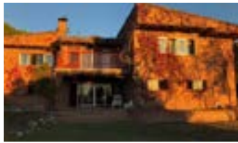
Estado de la fachada previo a la reforma
